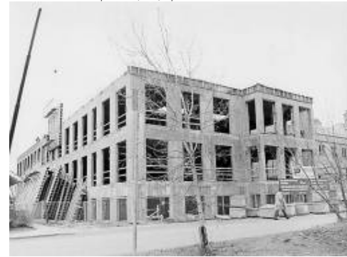
شكل رقم (24) شكل المبنى الإدارى أثناء الإنشاء، وتظهر الحوائط الخرسانية فيه .
