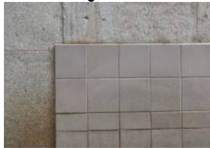
شكل رقم (11) استخدام حجارة Tyndall stone فوق قاعدة من precast concrete
